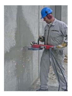
Отрезная пила HCS20 может использоваться как для горизонтальной, так и для вертикальной резки. Отрезная пила разработана для резки всех марок бетона, армированного бетона, стали, кирпича, асфальта и т.д.
